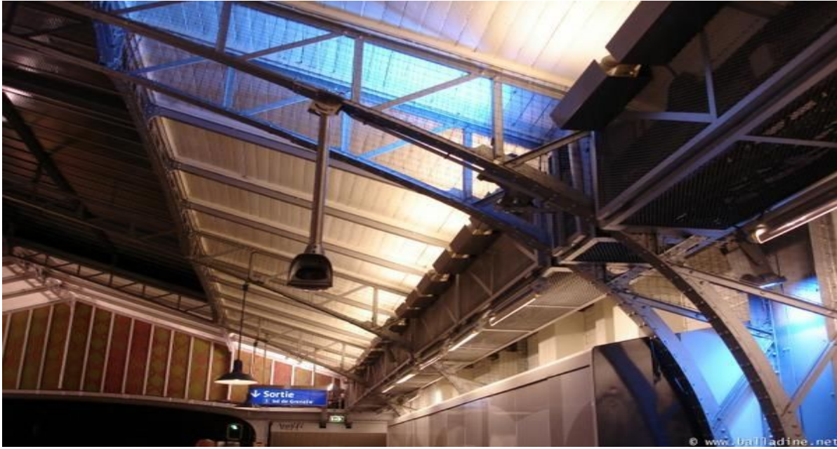
L'intérieur de la station à la tombée de la nuit Inside the station when night falls
